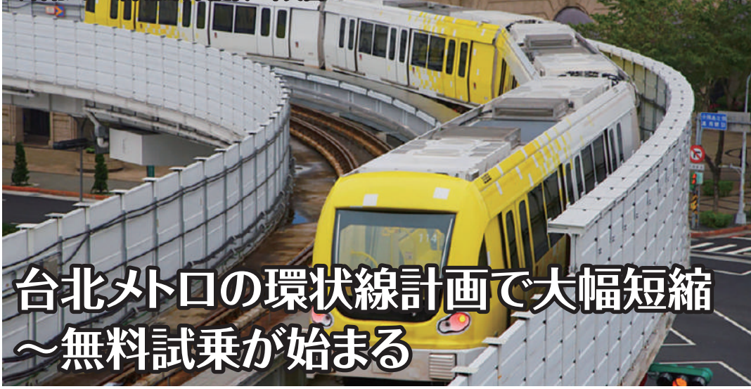
▼台北メトロ環状線(写真提供:中央社)
