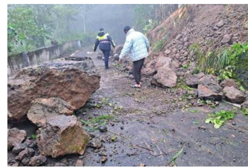
落石の被害(写真提供:中央社)
