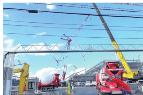
建設中のTSMC熊本工場(写真:中央社)
