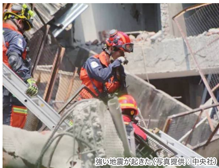
建物が傾斜(写真提供：中央社)
