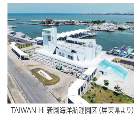
TAIWAN Hi 新園海洋航運園區 (屏東県より)
