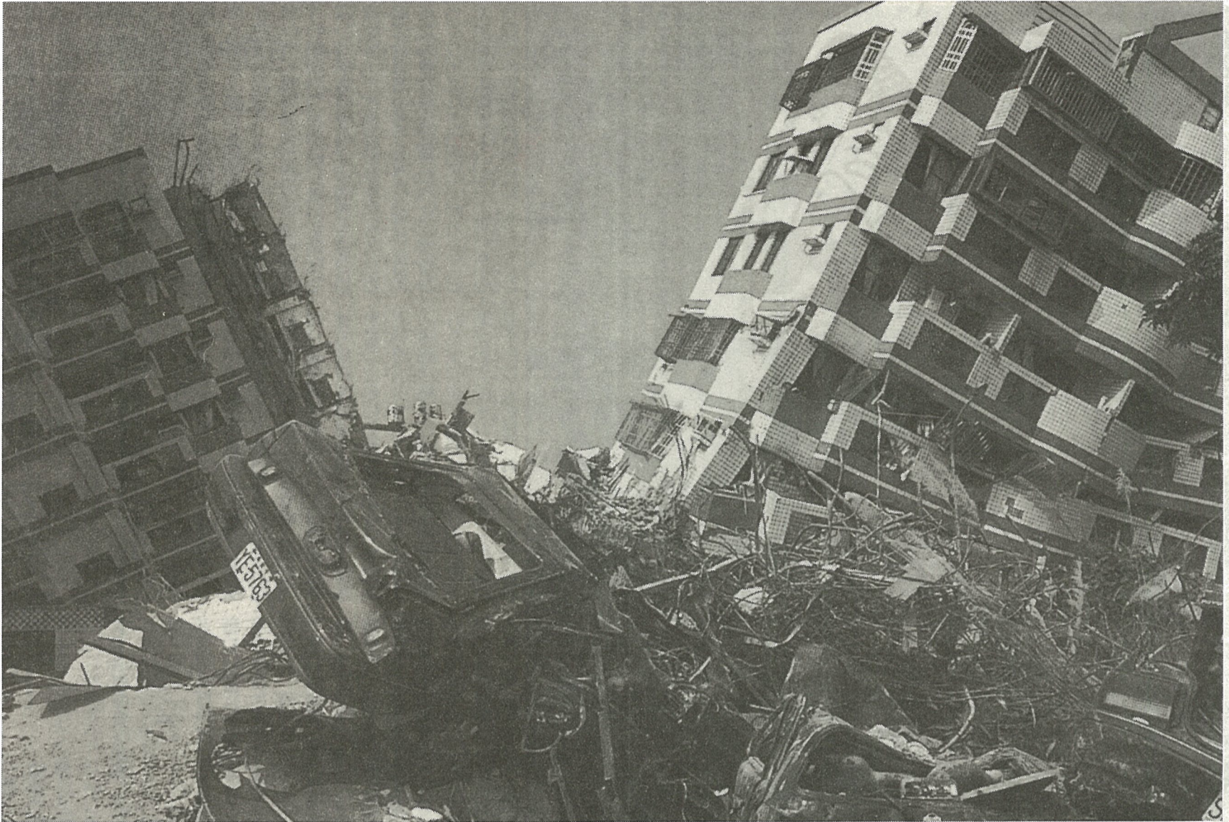
直下に走る活断層が動いたことにより左右に分かれて倒壊したビル。このため、多くの犠牲者が出た(雲林県斗六)
