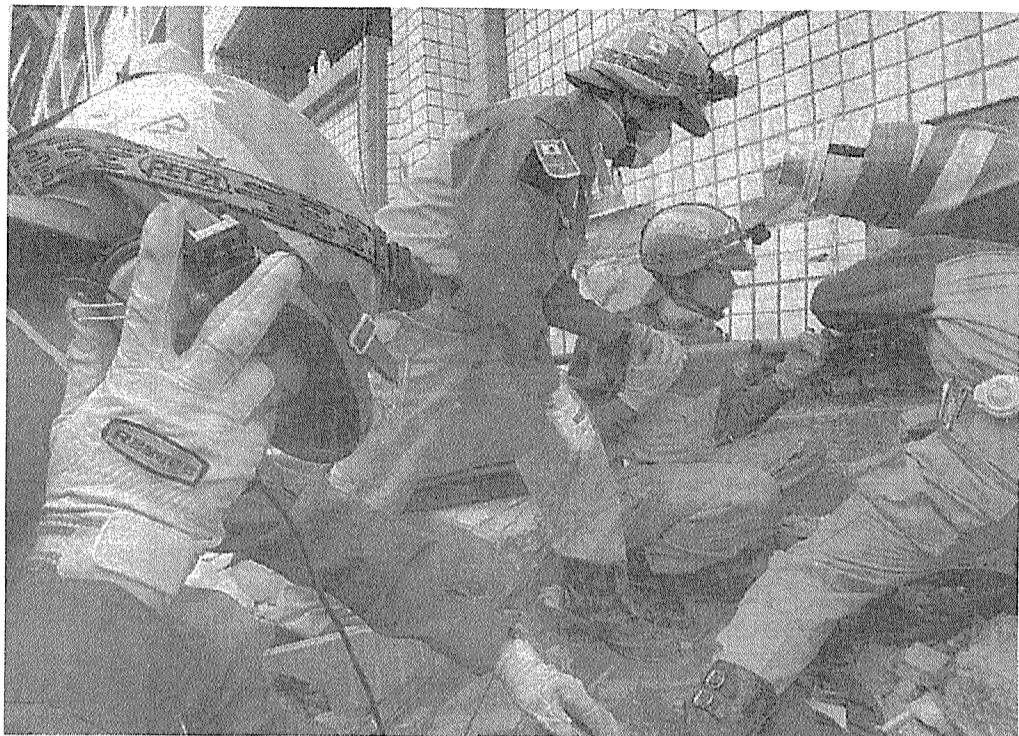
9月22日、南投県埔里で倒れたビルの中に生存者がいないか、確認作業に当たる日本のレスキュー隊。埔里は今回壊滅的な打撃を受けた
