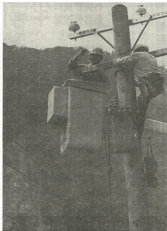
復興へのつち音高く…開始された電柱の修復工事
