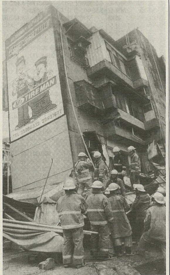
地震で崩れかけたビルに閉じ込められた人を捜し出す消防隊員ら(台北)
