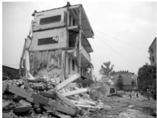
四川省汶川縣十二日發生芮氏規模八級強震。圖為重慶梁平一小學校舍被震垮，僅剩中樑。上方仍可見教室黑板懸掛於牆上。
