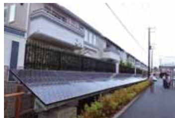
智慧城圍牆外設置太陽能面板，遇緊急災害時，可供電給附近居民
