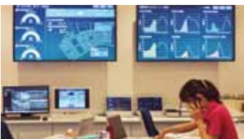
中央控制中心可管轄藤澤智慧城內的安全和掌握住戶用電狀況
