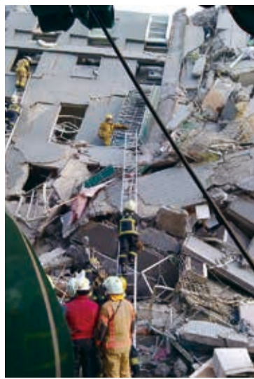
台南永康區維冠金龍大廈倒塌現場救援人員尋找生還者(照片提供:紅十字會)
